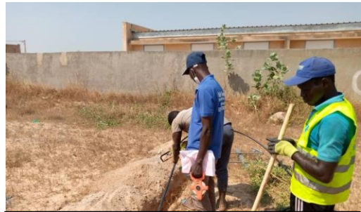
Travaux d'extension du réseau de la Sen'eau à Sangalkam.
